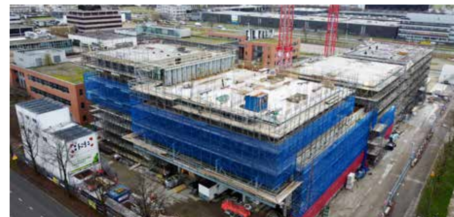
Relatief traditionele ruwbouw op basis van de wanden-breedplaatmethode.
